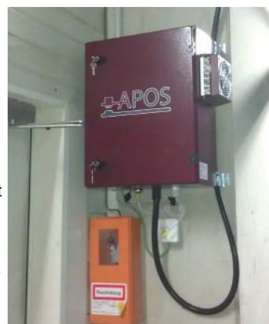
CSU en cours d'installation
